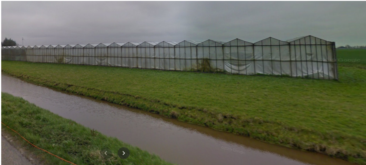
Aanzicht glasopstallen vanaf de Grote Zomerdijk (bron: GoogleMaps)
