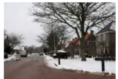
De architectonische uitwerking en detaillering zijn zorgvuldig en gevarieerd
