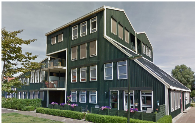
Figuur 13: Bouwcomplex zelf als ruimtelijk accent in traditionele stijl
