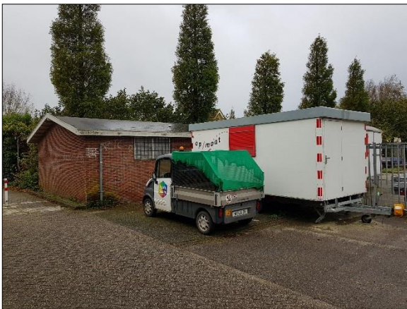
Figuur 7. Gebouw van voormalige gemeentewerf
