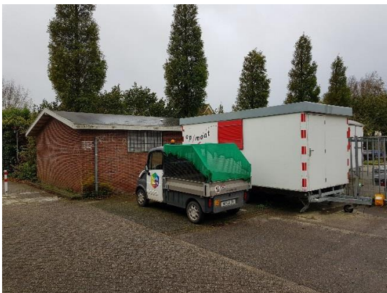
Figuur 9. Gebouw van voormalige gemeentewerf
