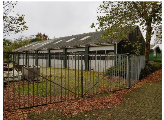
Figuur 4. Zuidelijke loods
