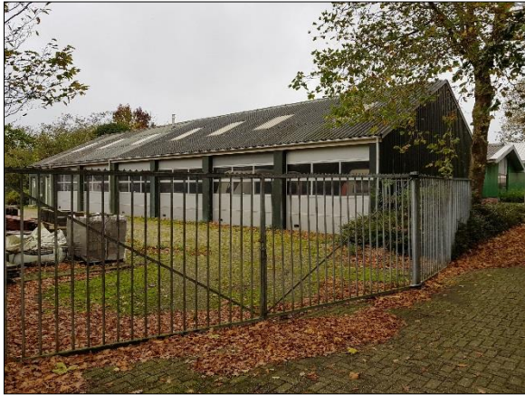
Figuur 4. Zuidelijke loods
