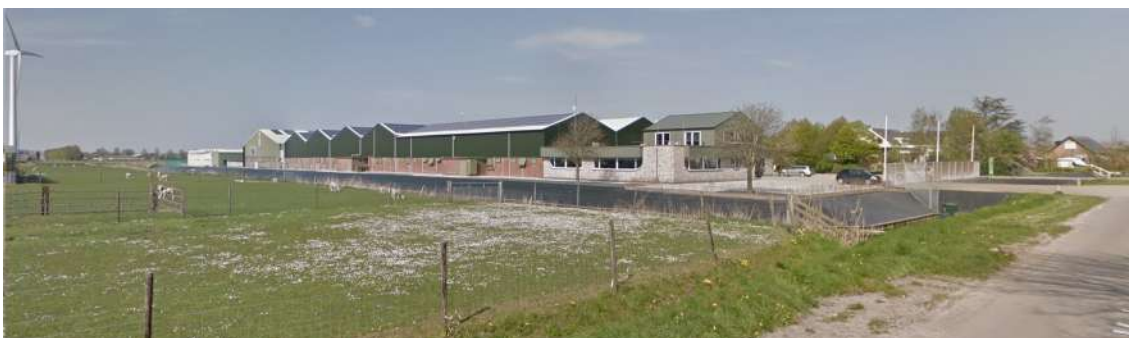
Figuur 2.2. Vooraanzicht westkant huidige situatie (bron: Google Streetview)
