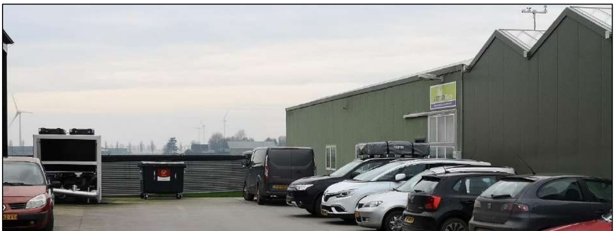
Afb 5: Loods waartegen gebouwd gaat worden
