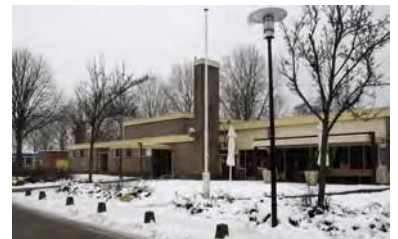
De architectonische uitwerking en detaillering zijn in het algemeen evenwichtig en sober
