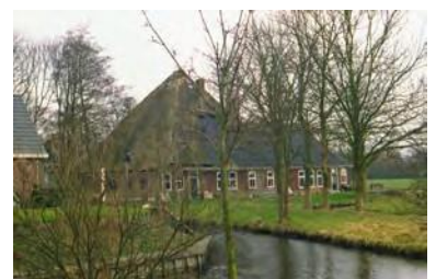
Naast eenvoudige huizen komen in deze linten ook enkele boerderijen voor
