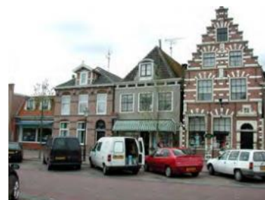
Dakkapellen in de goot als onderdeel van de architectuur van de voorgevel
