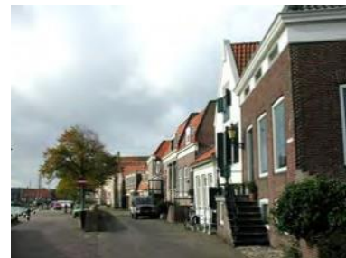
Straatwanden in de binnenstad bestaan uit individuele panden in klassieke architectuur
