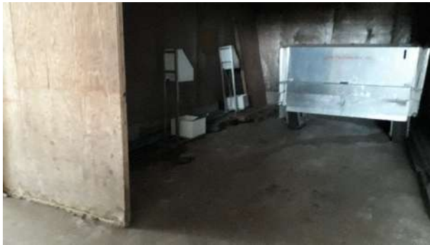
Foto 7: Schuur en betonvloer
