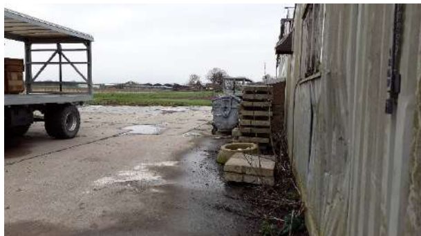
Foto 1: Schuur en betonweg
