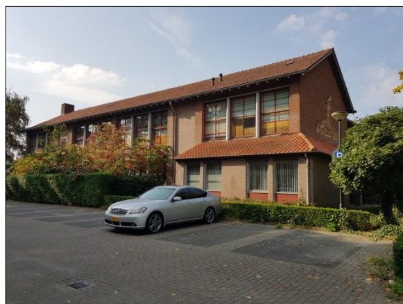
Figuur 4. Noordzijde complex
