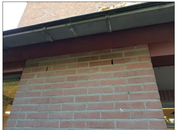
Figuur 10. Open stootvoegen
