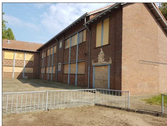
Figuur 3. Zijde van complex waar extra appartementen aangebouwd worden
