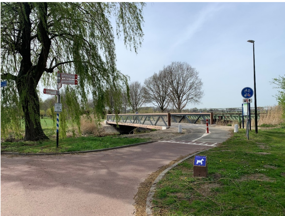
Nieuwe brug over de Aa (voorjaar 2022)
