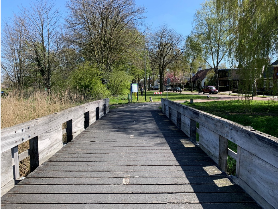
Voormalige brug over de Aa (voorjaar 2021)
