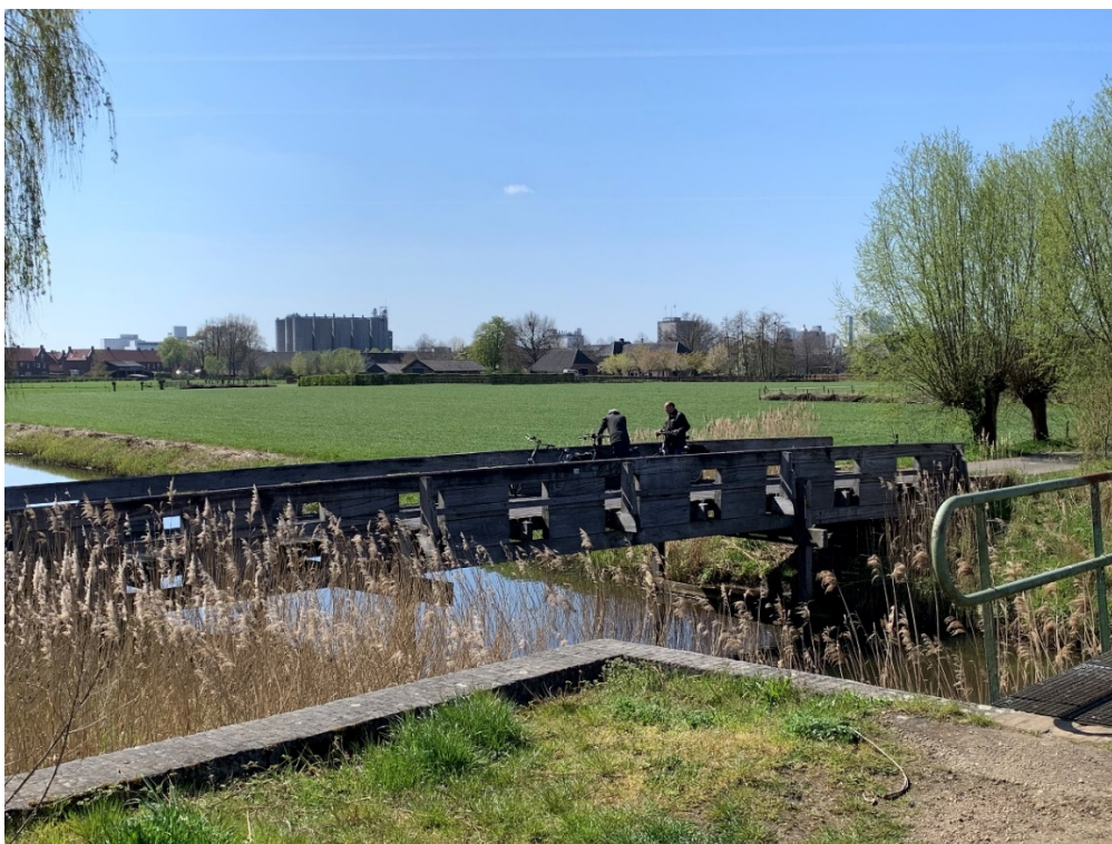
Voormalige brug over de Aa (voorjaar 2021)
