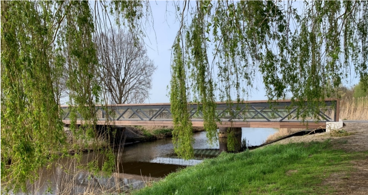
Nieuwe brug over de Aa (voorjaar 2022)
