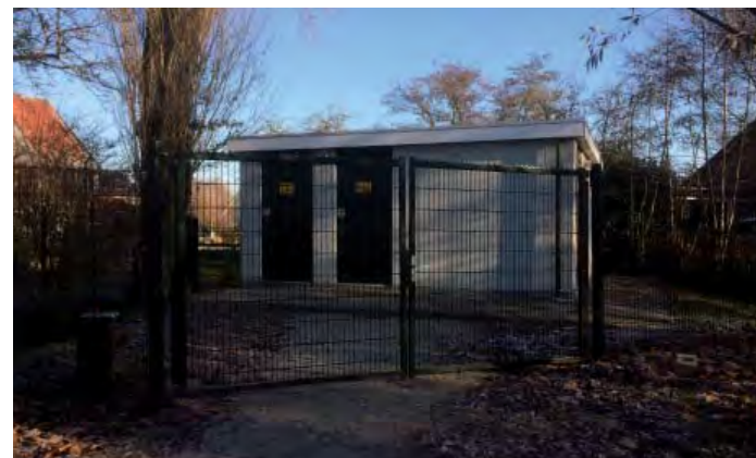
Bestaand elektragebouw aan de entree van het plangebied
