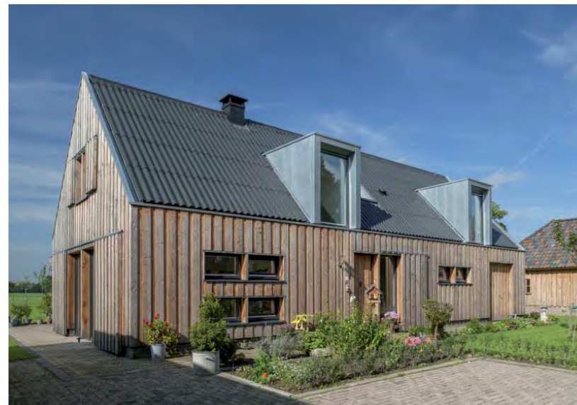
Schuurwoning, BAS architectuur
