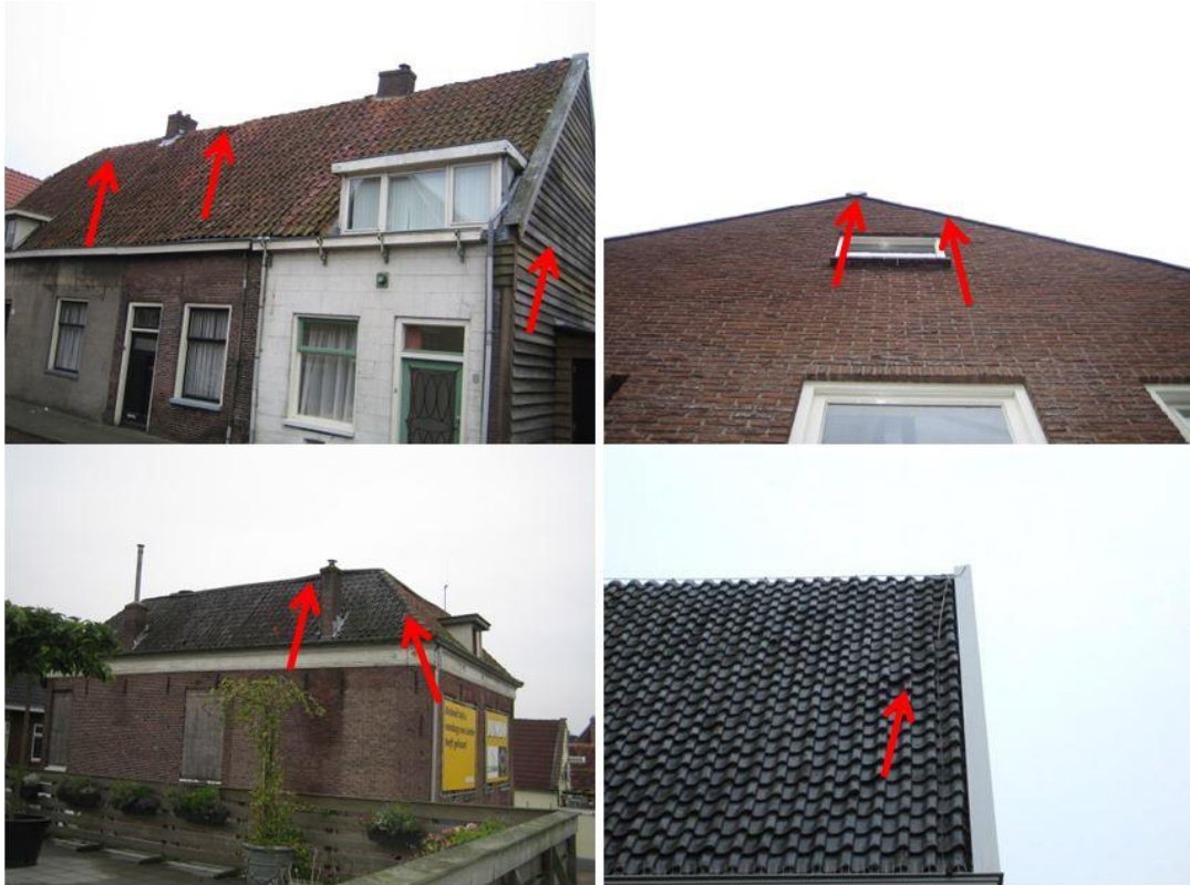
Enkele panden welke in potentie geschikt zijn als vaste rust- en verblijfplaats voor vleermuizen gelegen aan respectievelijk de Brink (4-8), Torenstraat (6), Holkerstraat (19 en 9), (SAB, 2013).
