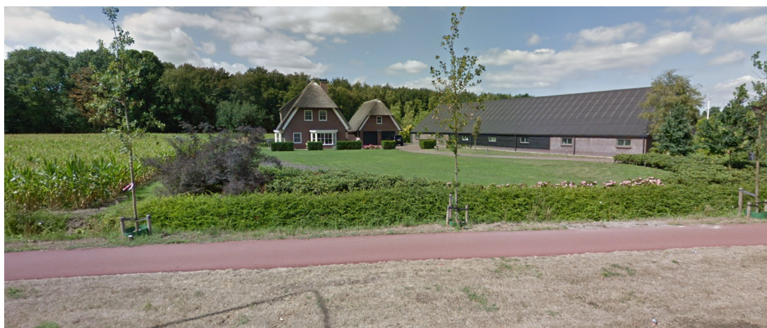
Zuidzijde plangebied vanaf Nijkerkerstraat (Bron: Google maps)
