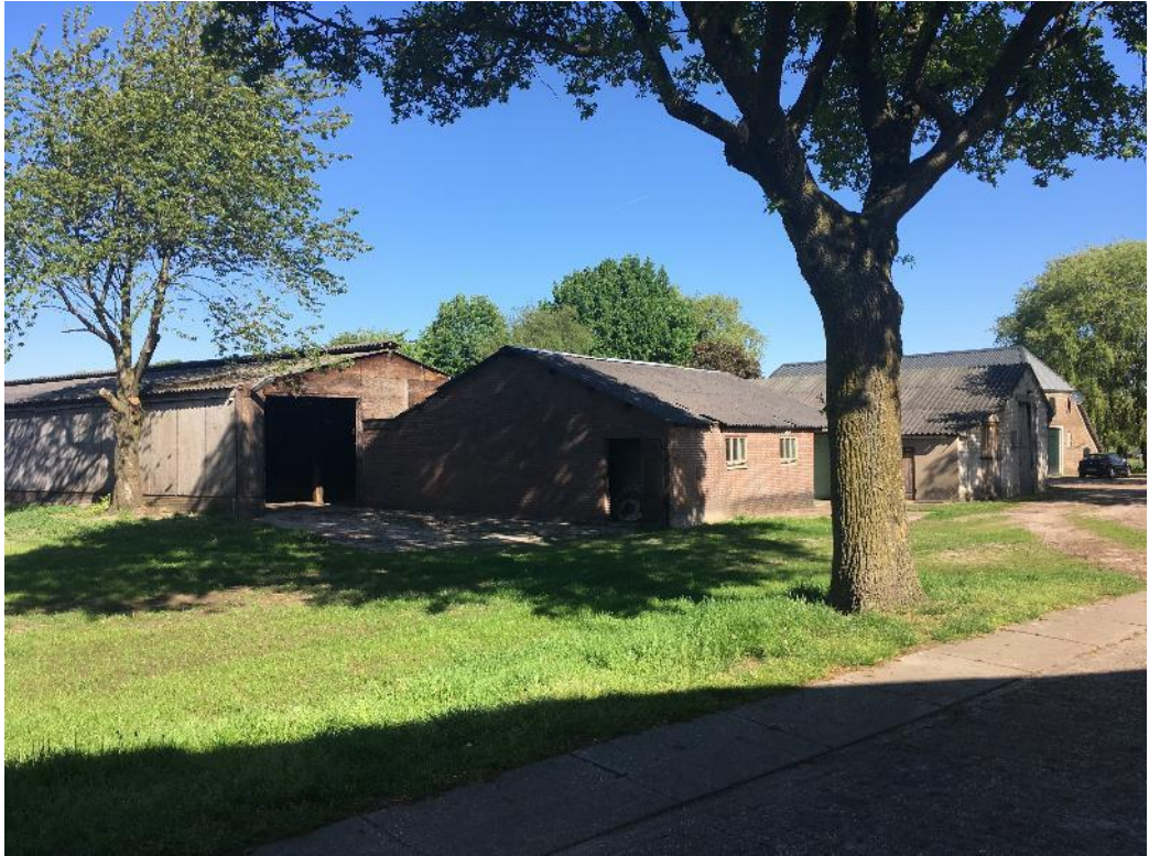
Figuur 3 Aan de noord- en westzijde van het perceel is een watergang gelegen. Aan de oostzijde is een pad van betonplaten gesitueerd. De opstallen zijn opgetrokken uit metselwerk of hout en dragen allen een golfplaten dak.
