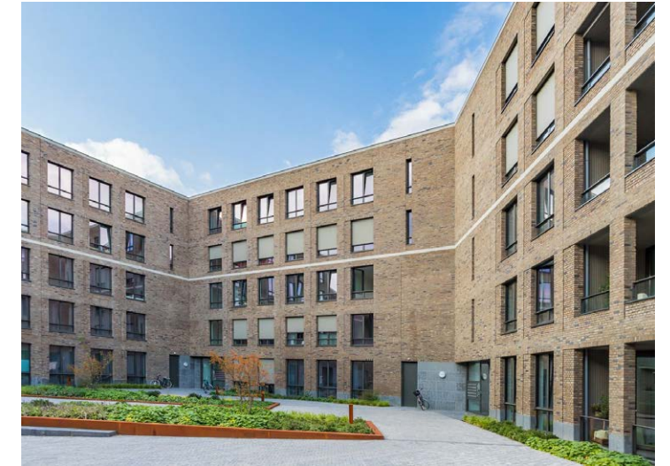
Voorkanten aan binnenplaats; Sphinxkwartier, Maastricht (Bedaux De Brouwer)
