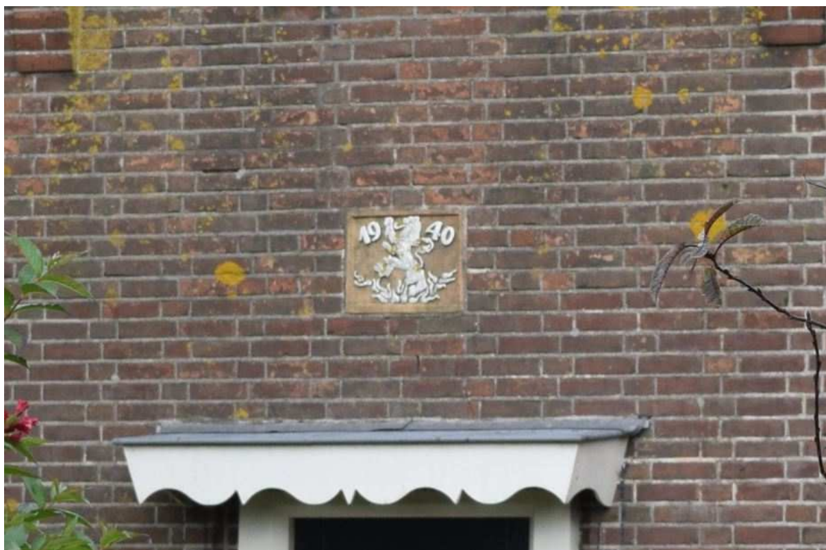
Figuur 55. Gedenkplaat na de brand in 1940. Bron: foto locatiebezoek BeoBOM, 8 oktober 2015.
