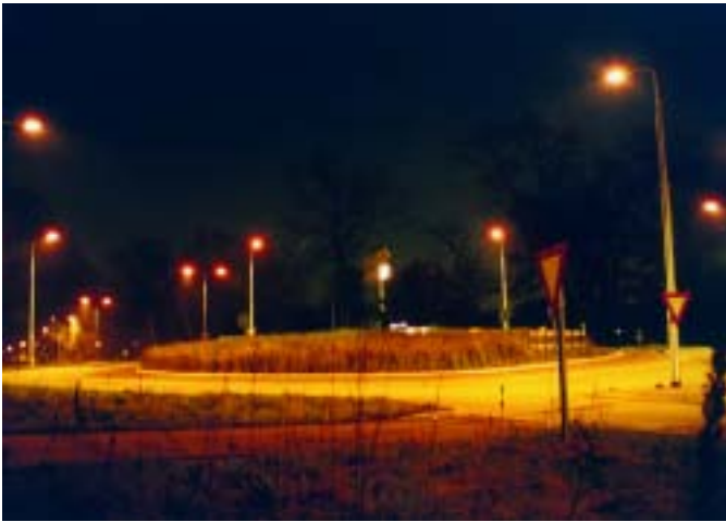
Rotondes. Altijd verlichten vanaf de buitenzijde.
