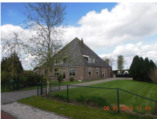
Jan Glijnisweg 1 (stolp op redelijk ruim erf)
