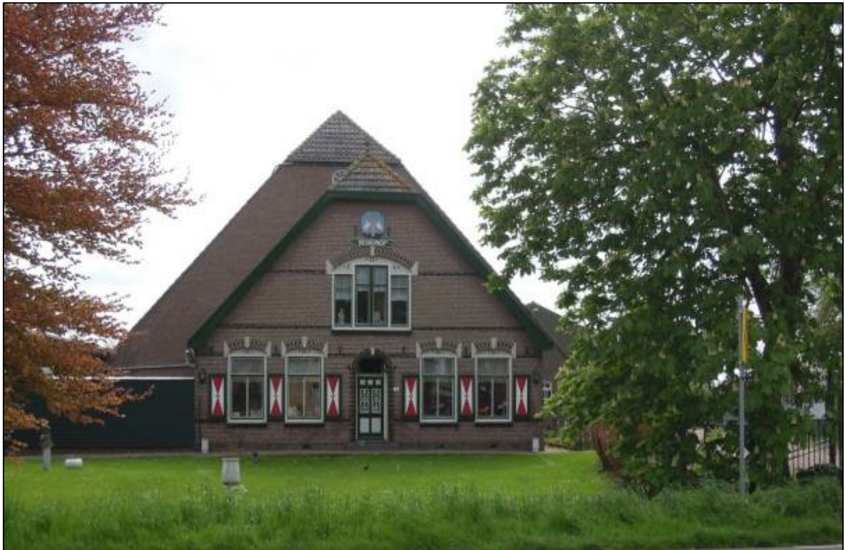
Afb. 48: Het "Reigerhof" aan de Rustenburgerweg 126 is gebouwd in 1915, gelegen op ruim erf en in bezit van Art-Nouveau stijkenmerken.
