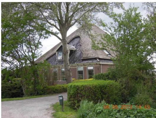
Veenhuizerweg 29, stolp met klokvormige spiegel
