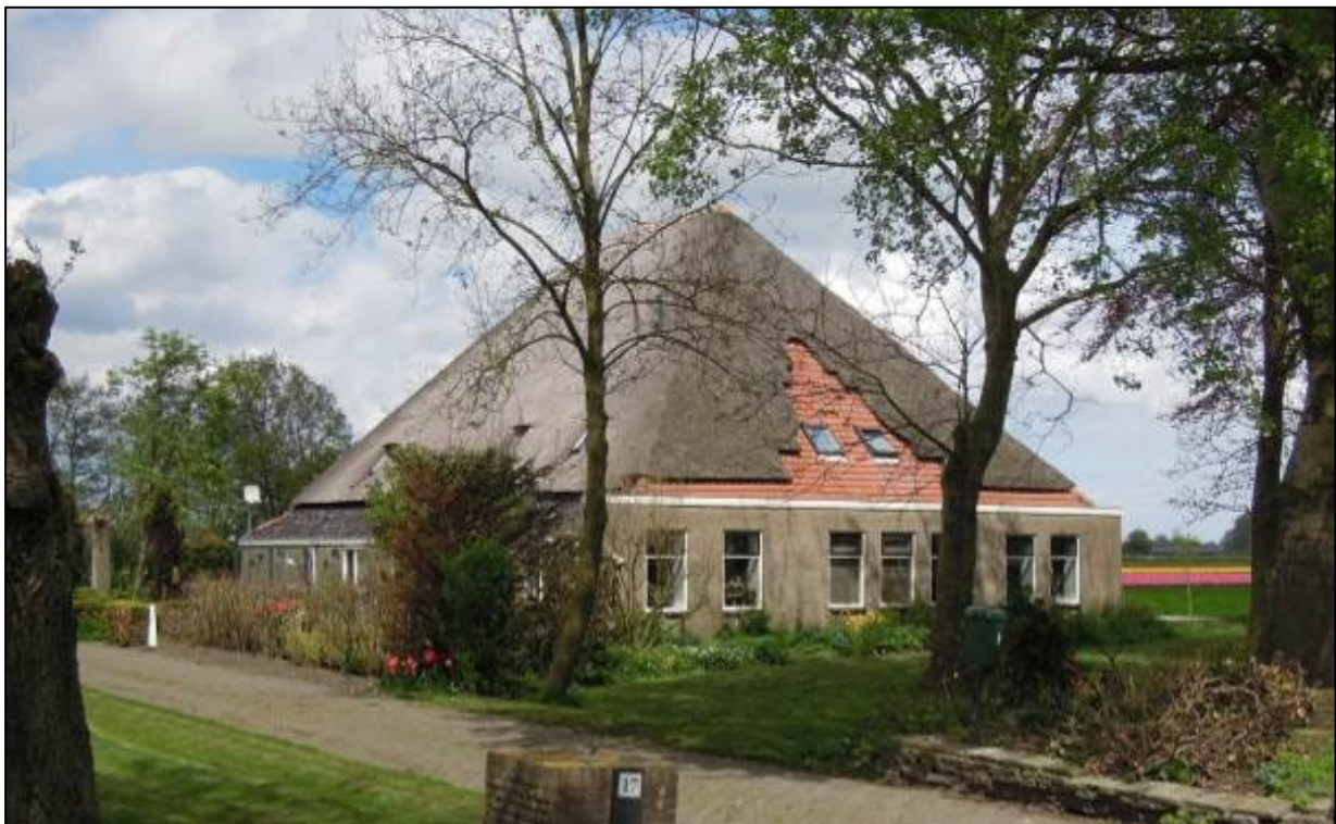
Afb. 18: De Kerkweg 17 is één van de drie stompboerderijen in Veenhuizen, die mogelijk nog een historische vierkantconstructie bevat.
