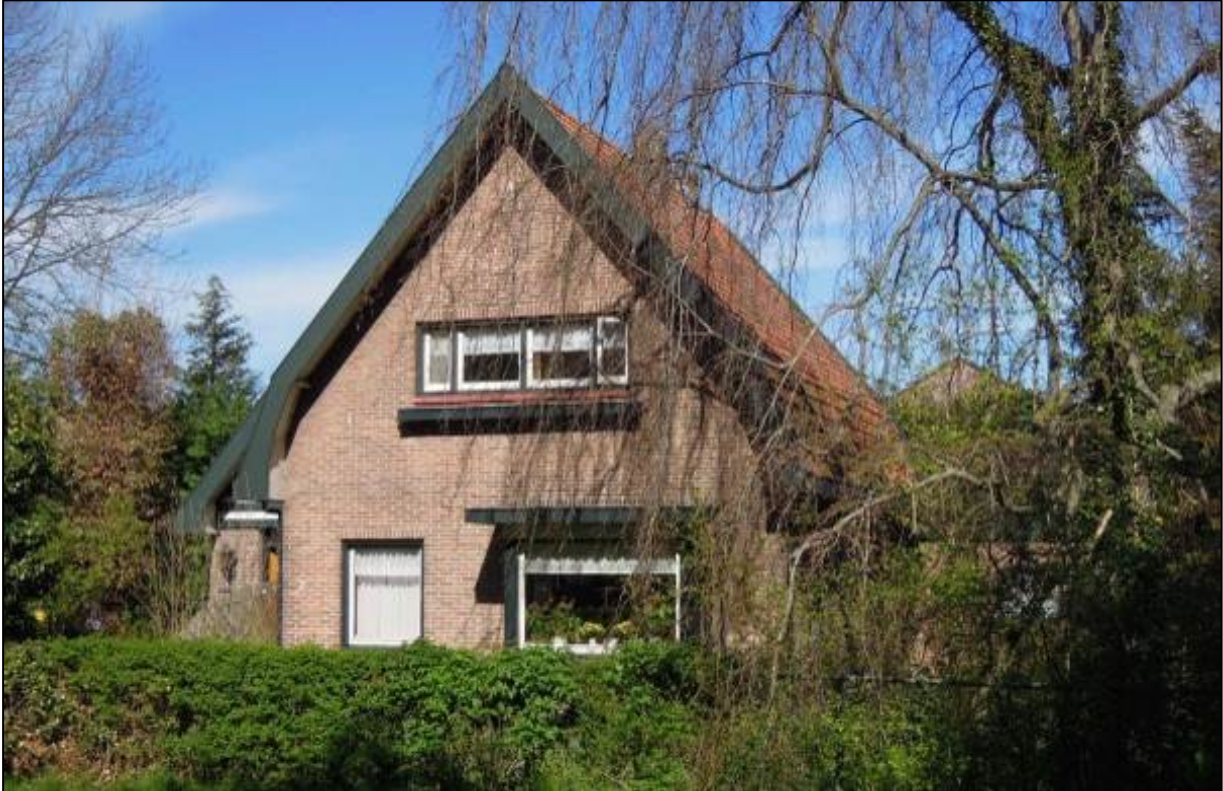
Afb. 45: De tuinderswoning aan de Middenweg 33 is kenmerkend voor de jaren dertig.
