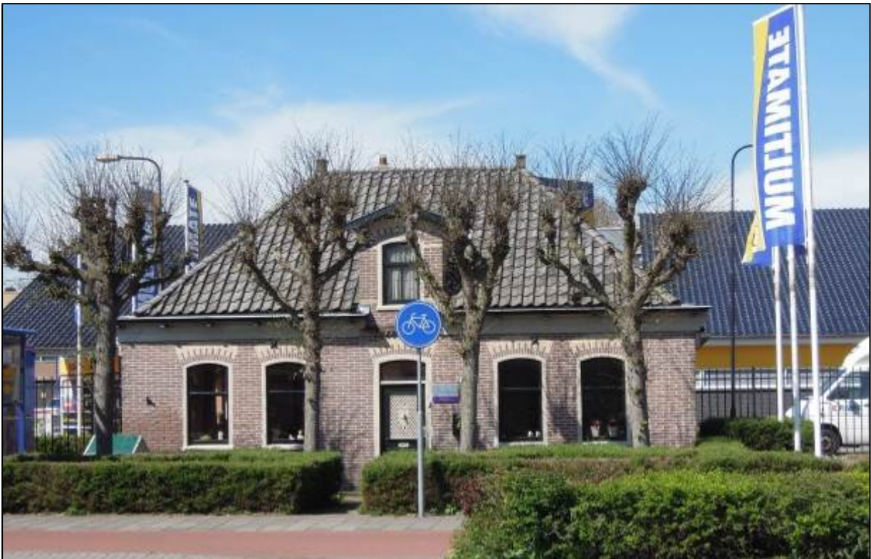
Afb. 46: De rentenierswoning aan de Middenweg 271 was gebouwd voor de ouders wanneer de kinderen de boerderij overnamen. Bij deze rentenierswoning is de boerderij niet meer aanwezig.
