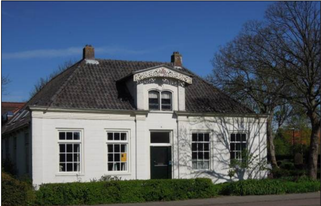
Afb. 50: Aan de Middenweg 179 staat het gebouw dat van 1835 tot 1914 als raadhuis dienst heeft gedaan.
