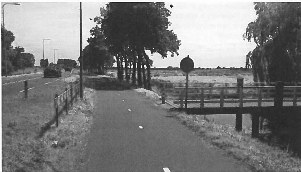
Figuur 19: foto fietsbrug van de gemeente Opmeer
