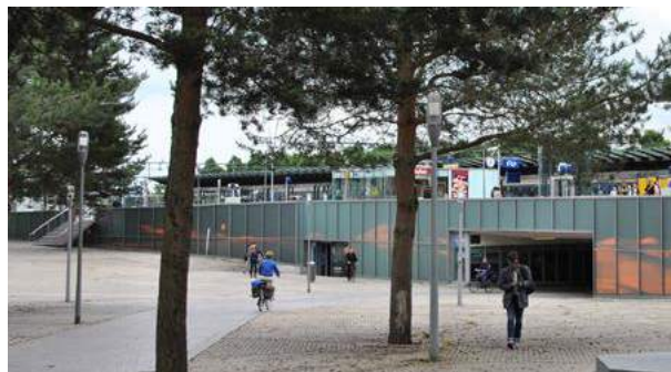
Plein met glooiende overgang naar fietstunnel
