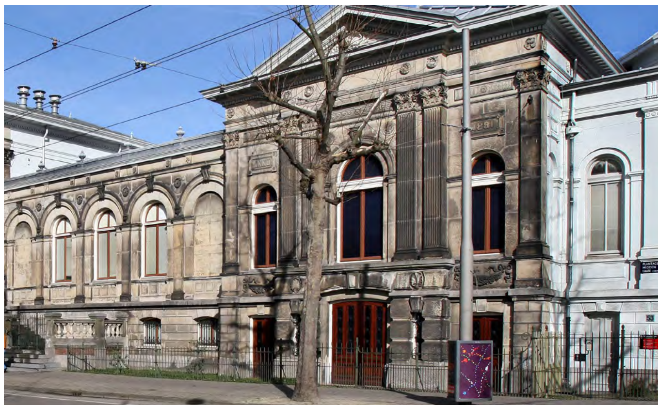
Voorgevel huidige situatie
