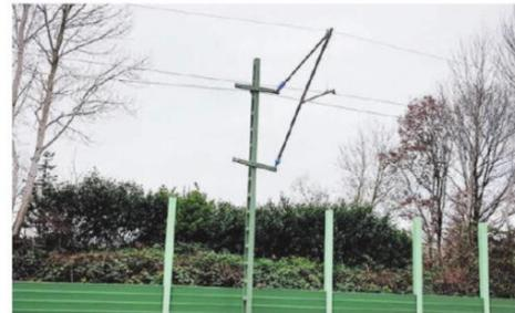
Grundstruktur der Oberleitung im Bau: Erkennbar sind bereits Mast, Halter, Trageseil, Fahrdrabt, Stromspeiseführung
