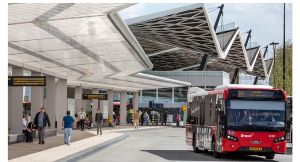
5.2: Busstation Tilburg: sprekende dakvorm
