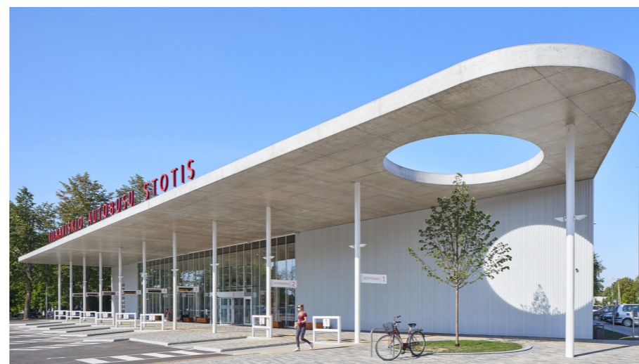
5.1: Busstation in Vilkaiviškis: overstekken bieden schaduw en beschutting
