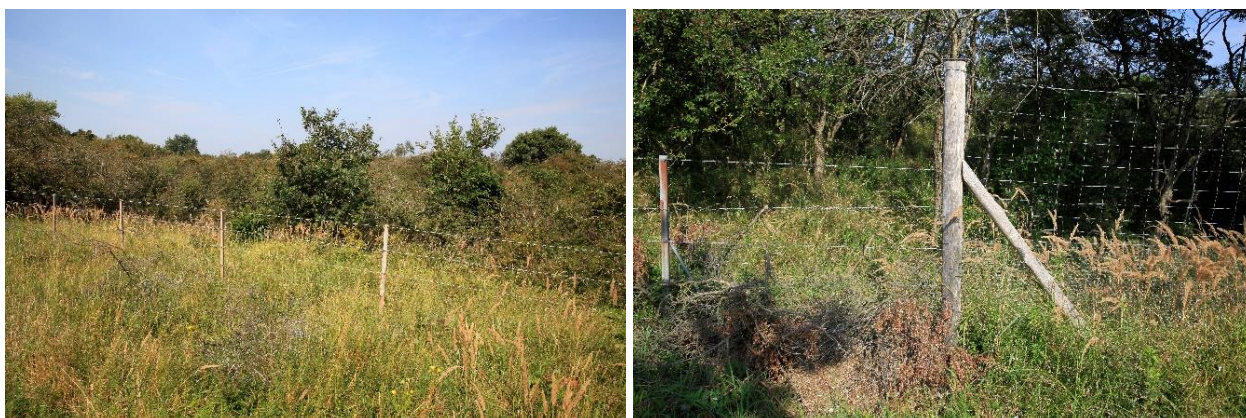
Figuur 6 Standaardraster (links) – 1,2 m hoog en bestaande uit een 5-draadsraster – en de aansluiting van dit standaardraster op het hoge faunaraster (rechts).
