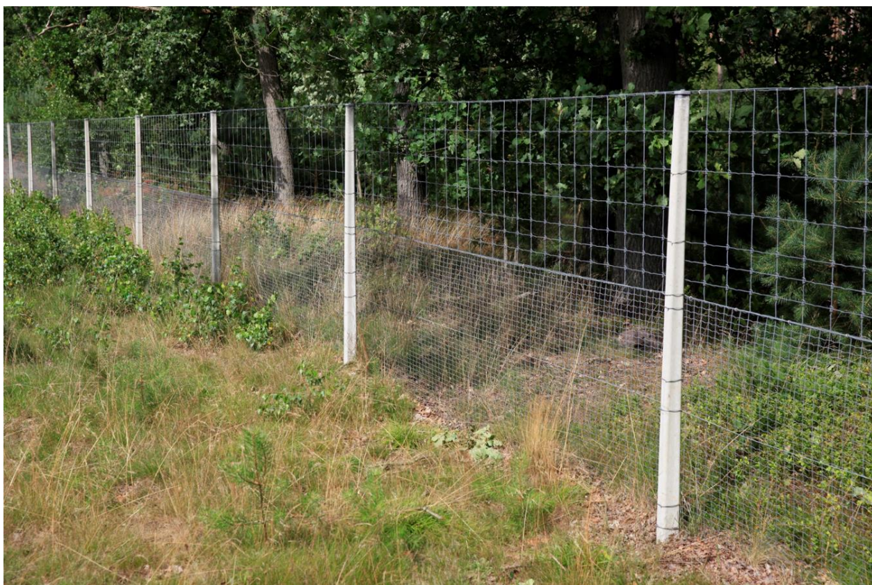
Figuur 15 Een circa 2 m hoog faunaraster dat bedoeld is om reeën tegen te houden.
