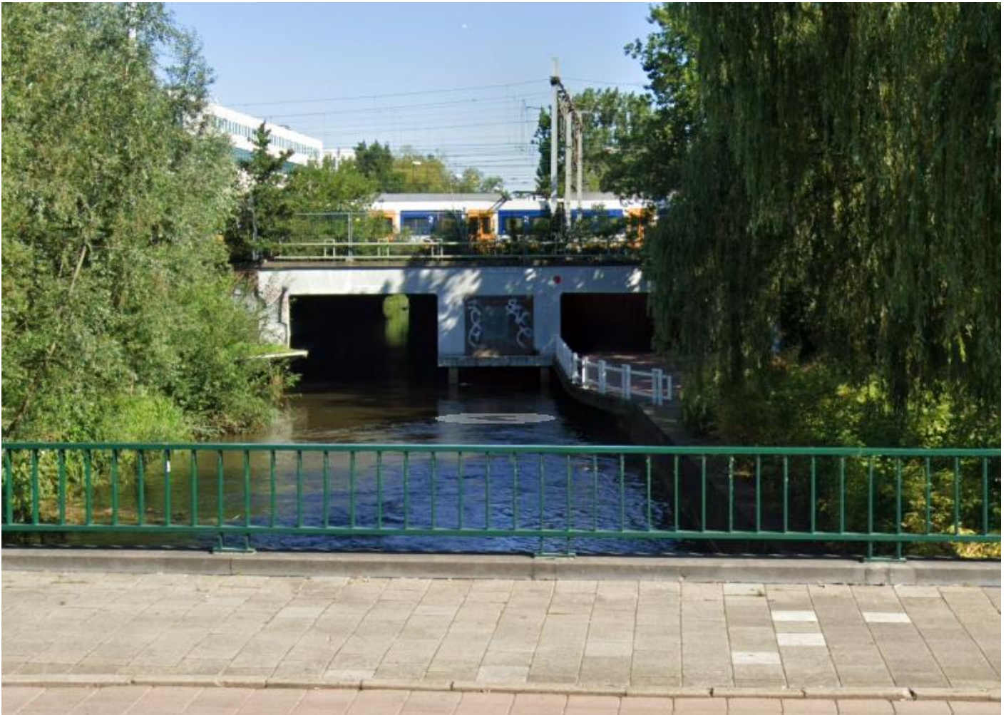
Huidige beeld Dommelpassage vanuit het zuiden (Stationsweg).
