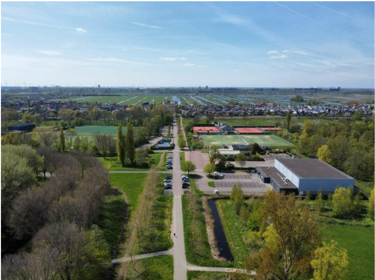
Foto 7: Sporthal aan de westkant van de beoogde locatie
