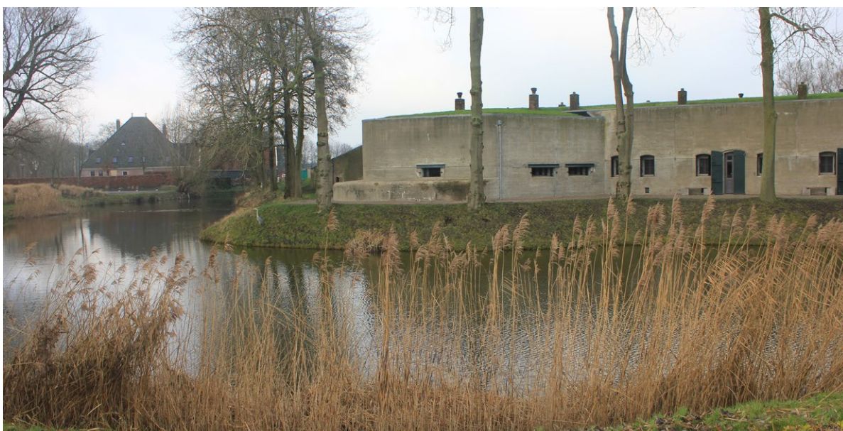
Zicht over de gracht van Fort aan de Nekkerweg richting de Volgerweg met stolpboerderijen.
