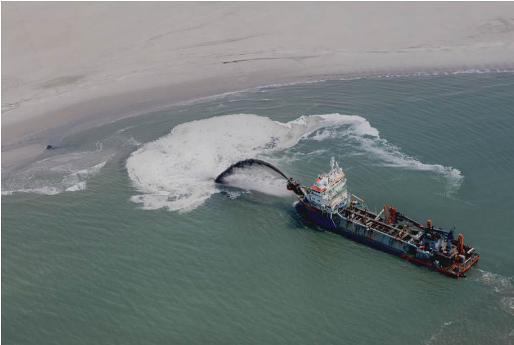
Foto 2.5. Kustbescherming door zandsuppletie. (Foto Joop van Houdt)
