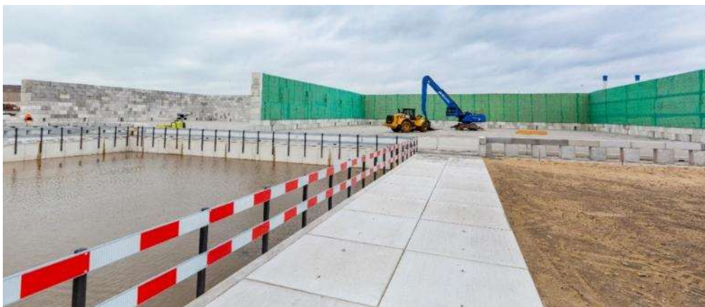
Figuur 4.5 Eén van de schrotopslagen van Tata Steel (bron: Tata Steel)
