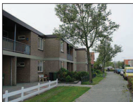
Appartementen Van Duivenvoordestraat
