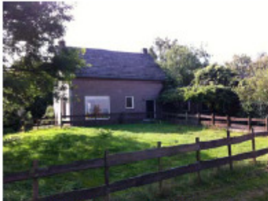
Bestaande (bedrijfs) woning en bedrijfsbebouwing
