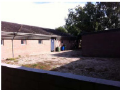
Bedrijfsbebouwing en zij-ingang vanaf het Spoorpad
