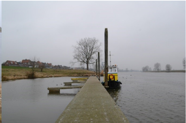
Figuur 3.3 Aanlegsteiger en houten palen
