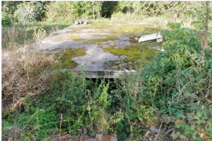
Afbeelding 3: Toegang tot de kelder
