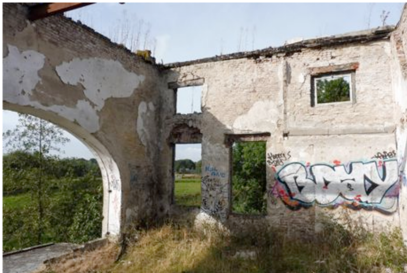
Ruïne van het gemaal van binnen gezien
