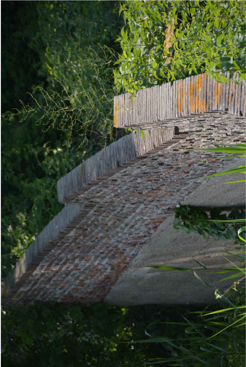
Bovenaanzicht keermuur zuidgevel
