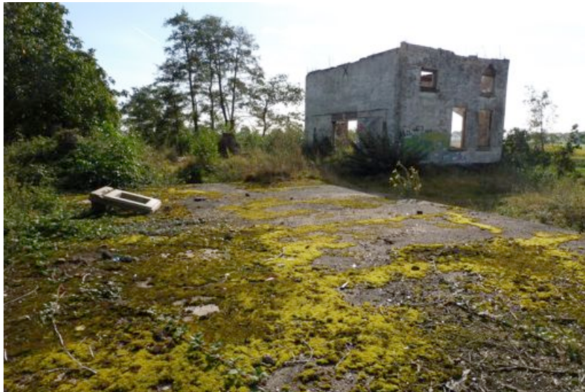
Ruïne van het gemaal, op de voorgrond de betonnen afdekking van de kelder
