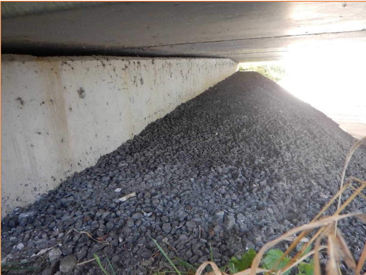
Afbeelding 3 Brug over Hertogswetering (30 oktober 2017)
