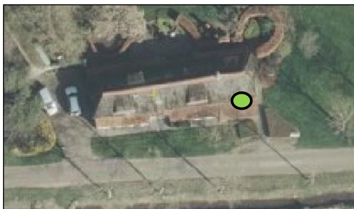
Raktstraat 8. Eén verblijfplaats bevindt zich aan de zuidoostzijde van het gebouw met één gewone dwergvleermuis.
