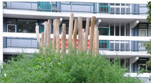
Figuur 3: uitkijktoren (onder constructie) in de Zonnehof in Duivendrecht
