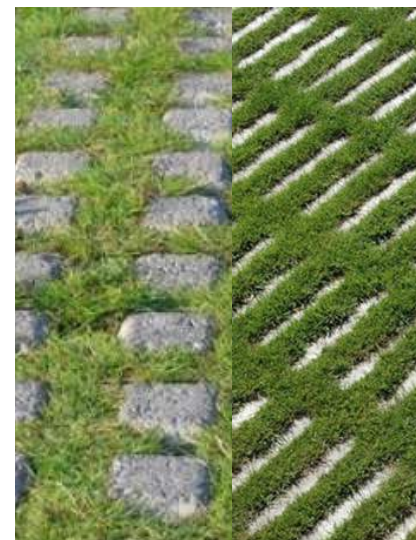
Afbeelding 5.11 Groene betonstenen zorgen dat het maaiveld beloop en -rijbaar zijn.
