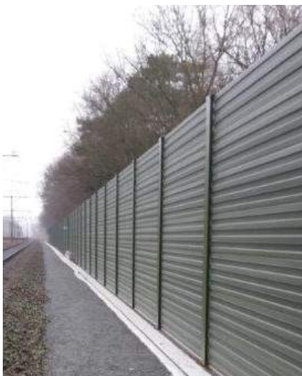
Afbeelding 5.8 Aluminium geluidsscherm ProRail
