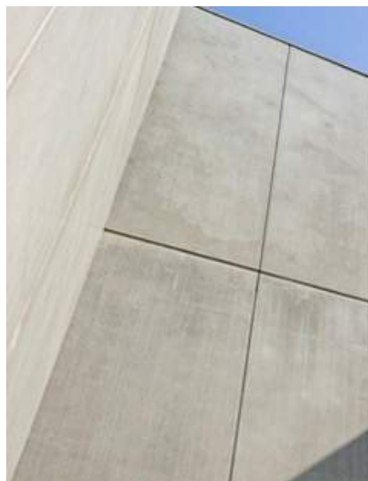
Afbeelding 5.9 Afwerking met schoonbeton en naadvoering tussen de panelen
