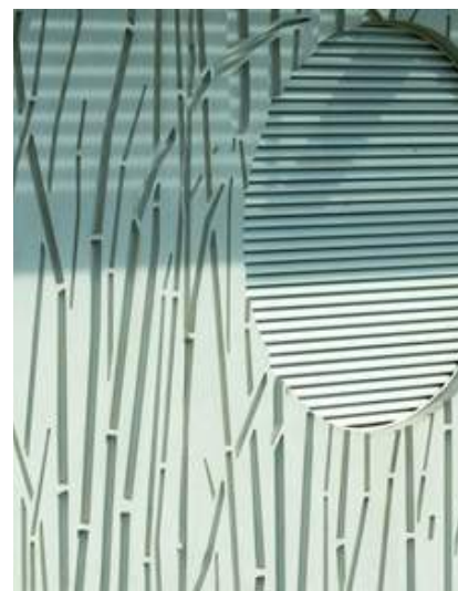
Afbeelding 5.10 Relief en textuur in de afwerking van het beton door hoogwaardige bekisting
