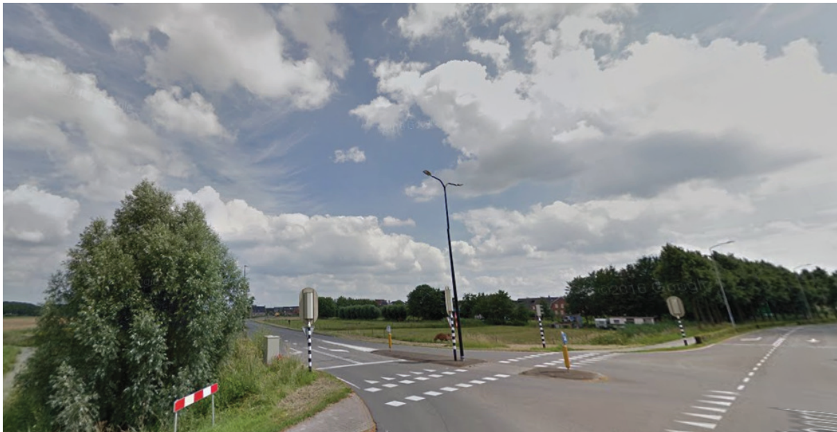
Afbeelding 7: Kruising Rijksweg-Noord - Ceintuurbaan met zicht op Groenordstrip (bron: Google Maps Streetview)
