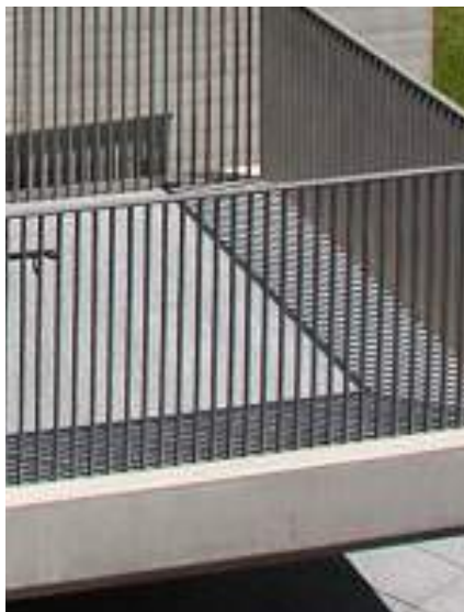
Afbeelding 5.7 Ranke maatvoering en integrale vormgeving tussen handreling en spijlen
