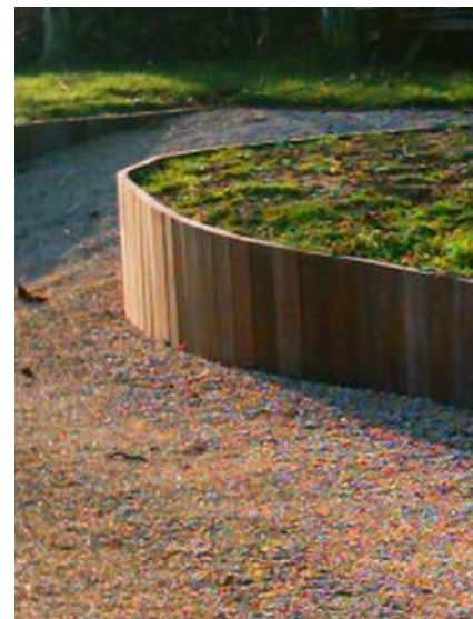
Afbeelding 5.8 Grote hoogteverschillen oplossen door kerende constructie (rechts, Cor-ten en links een houten keerwand)
