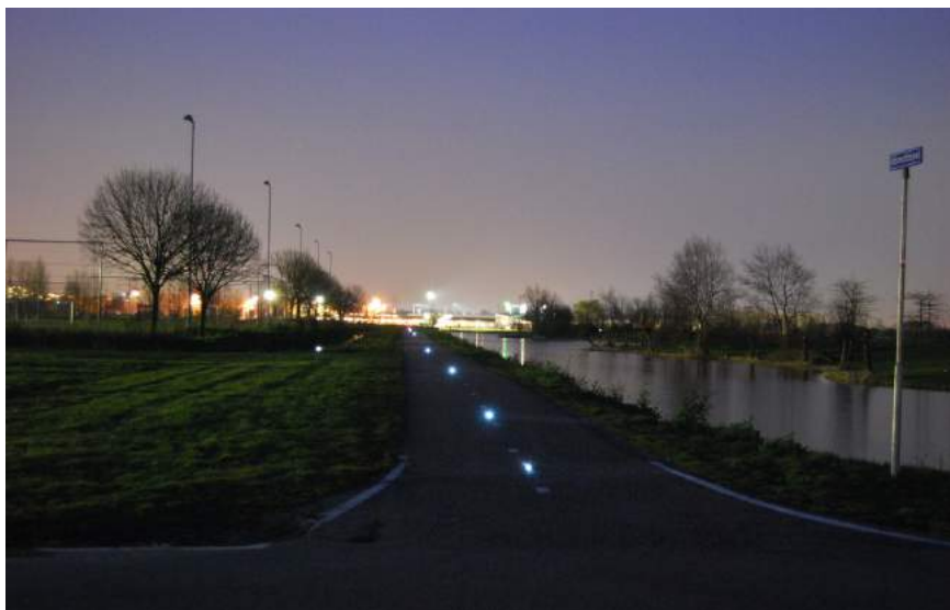
Afbeelding 5.11 Verlichting geïntegreerd in het asfalt
