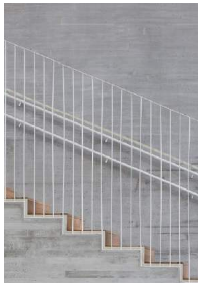
Afbeelding 5.7 Ranke maatvoering en integrale vormgeving tussen handreling en spijlen
