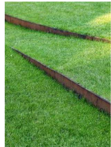
Afbeelding 5.8 Grote hoogteverschillen oplossen door kerende constructie (rechts, Cor-ten en links een houten keerwand)
