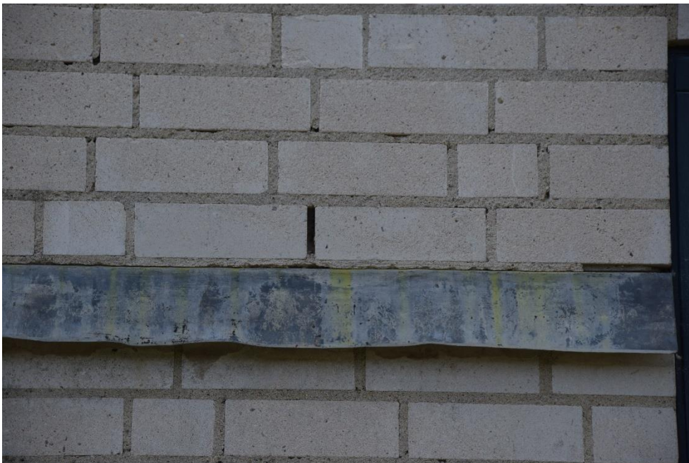
2 Open stootvoeg met toegang tot de spouw.
