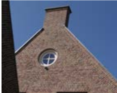
Schoorsteen als tuit van tuitgevel
