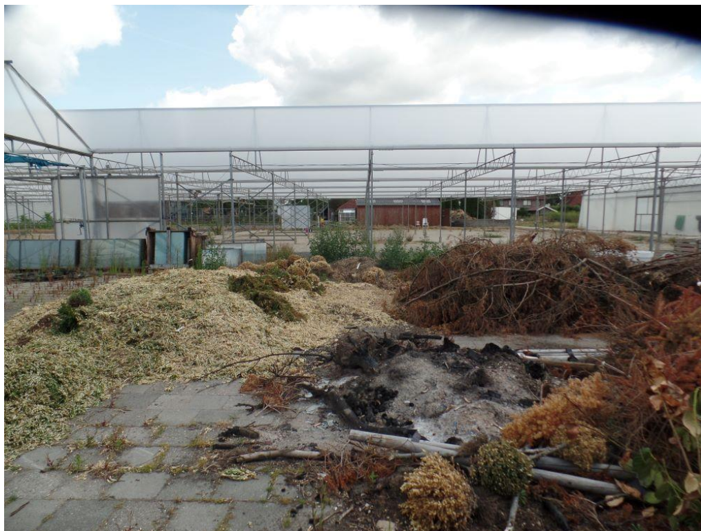
Figuur 5 Kassencomplex, deel gesloopt
