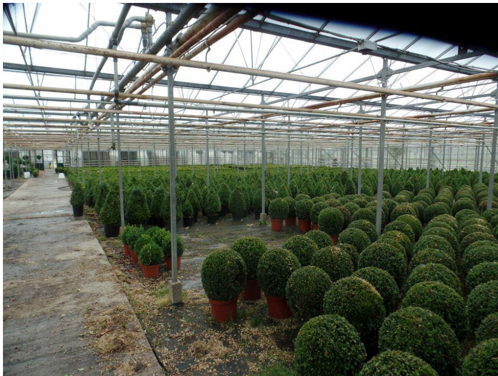
Figuur 3 Kassencomplex, deels in gebruik
