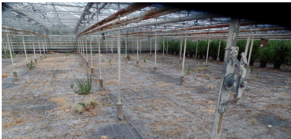
Figuur 4 Kassencomplex, deels buiten gebruik
