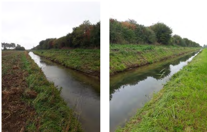
Afbeelding 10 Grondlichaam langs de Betuweroute gezien vanaf de overzijde van de sloot, is zuidoostelijke richting (links) en in noordwestelijke richting (rechts). Bron: foto Vestigia.
