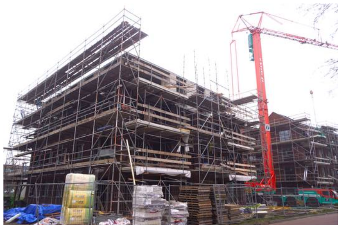
Een woonwijk in aanbouw. © GinoPress B.V.
