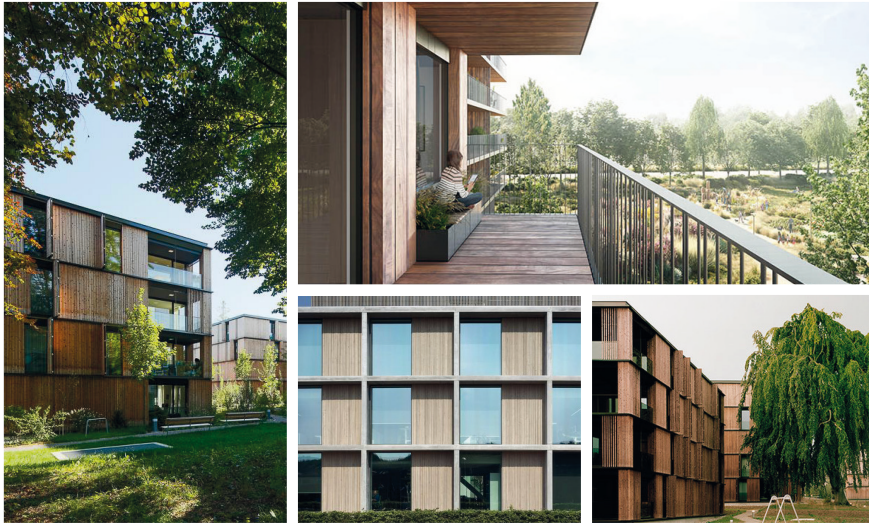
Referentiebeeld voor de bouwtypologie van de noordwestelijke en zuidoostelijke bouwclusters (uit: pres-veld 26 en 27 zuidrand Schuytgraaf, gemeente Arnhem, 2021-09-02)
