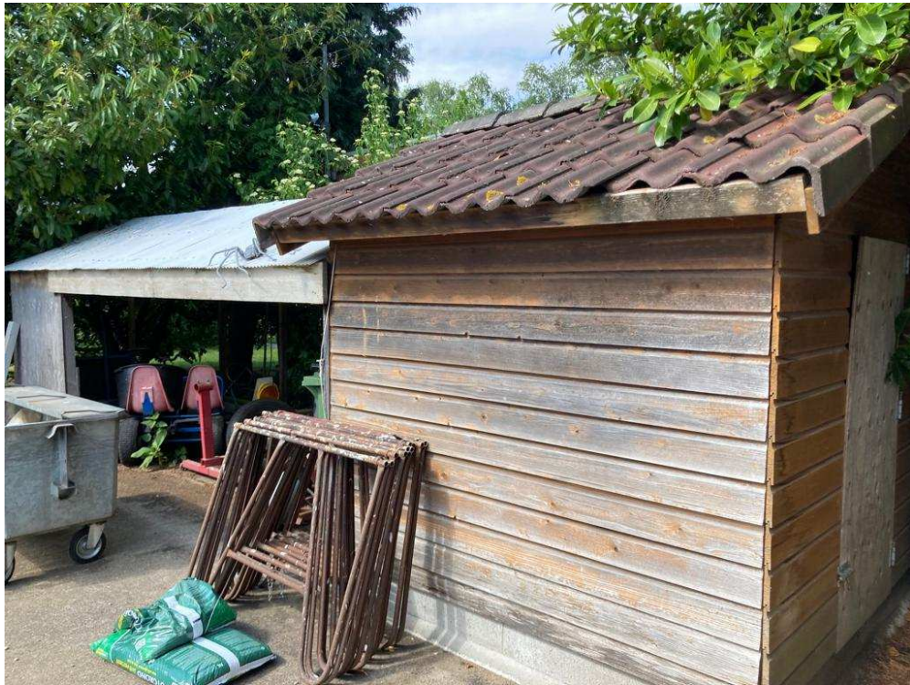
• Afbeelding 11: Te slopen schuur 3
