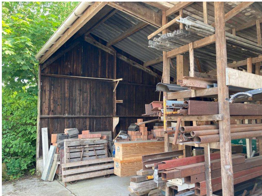
• Afbeelding 4: Andere zijde te slopen schuur 1
