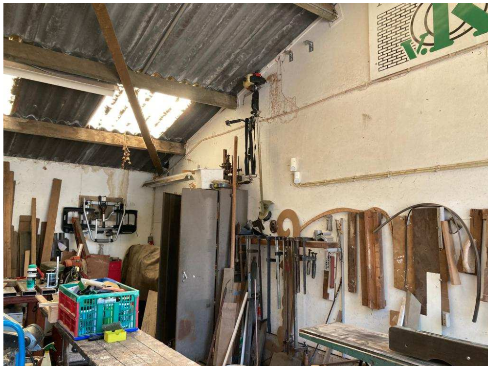
• Afbeelding 6: Binnenkant te slopen schuur 1
