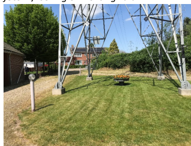
foto 5 / boring 07 richting west
