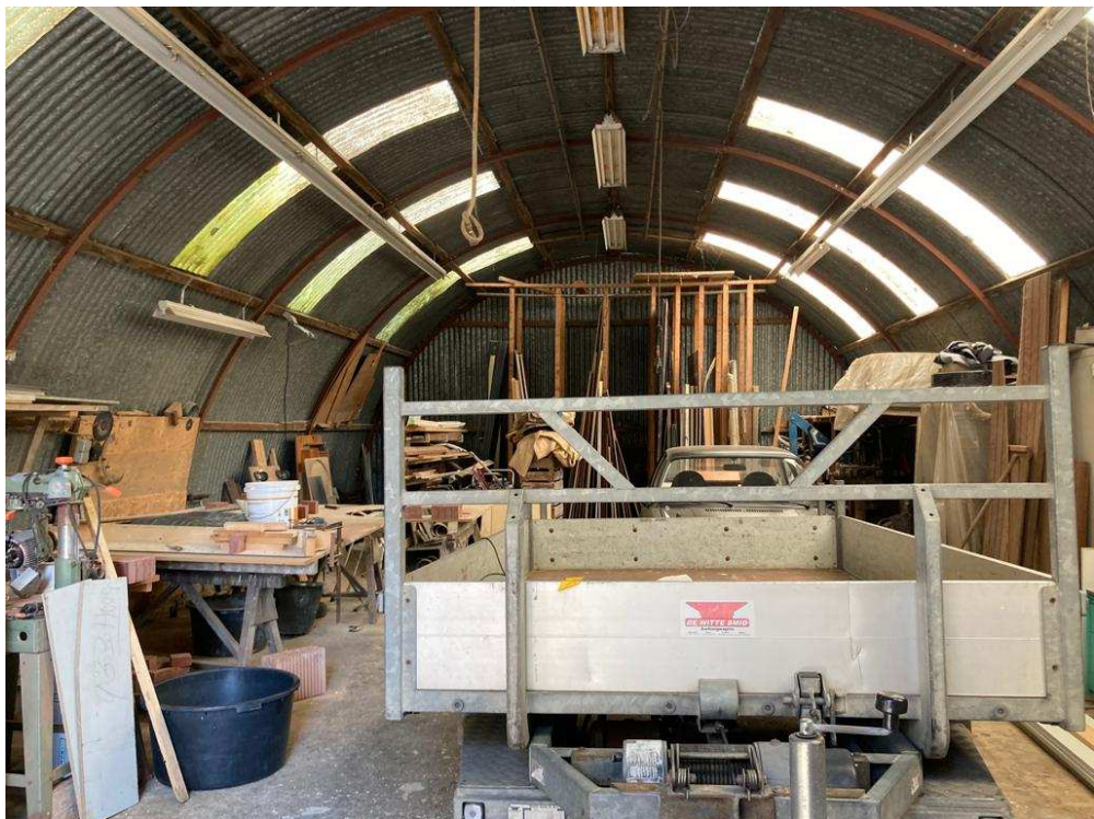
• Afbeelding 10: Binnenkant te slopen schuur 2
