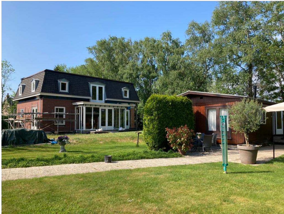
• Afbeelding 15: In aanbouw zijnde woning
