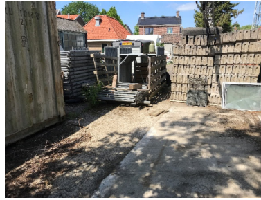
foto 8 / boring 13 richting west
