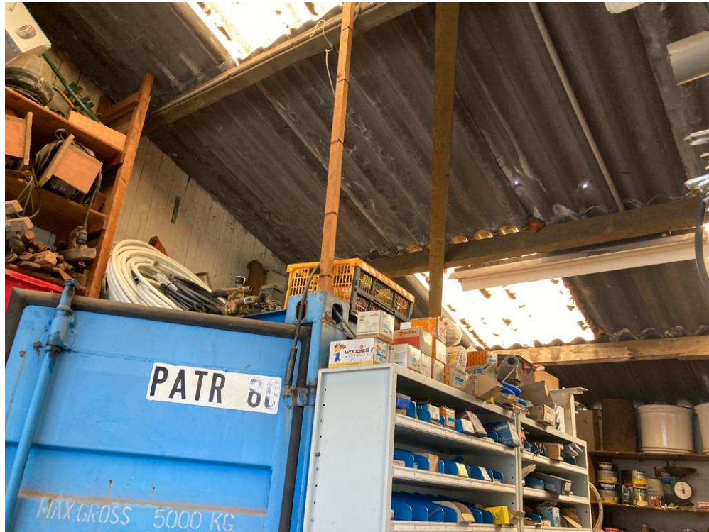
• Afbeelding 5: Binnenkant te slopen schuur 1
