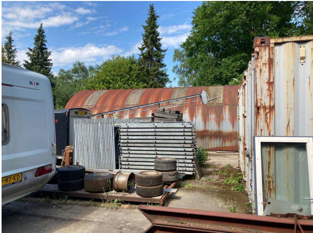
• Afbeelding 8: Zijaanzicht te slopen schuur 2
