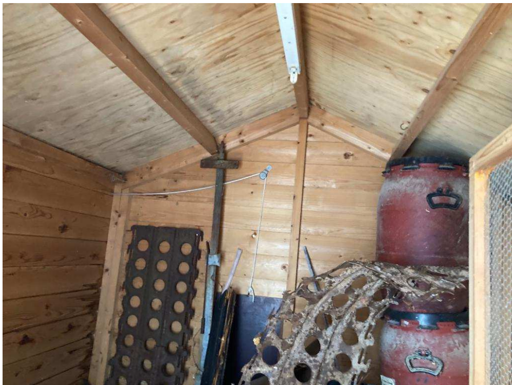
• Afbeelding 12: Binnenkant te slopen schuur 3
