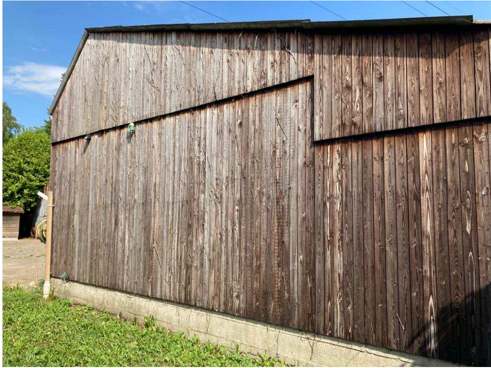
• Afbeelding 7: Zijkant te slopen schuur 1
