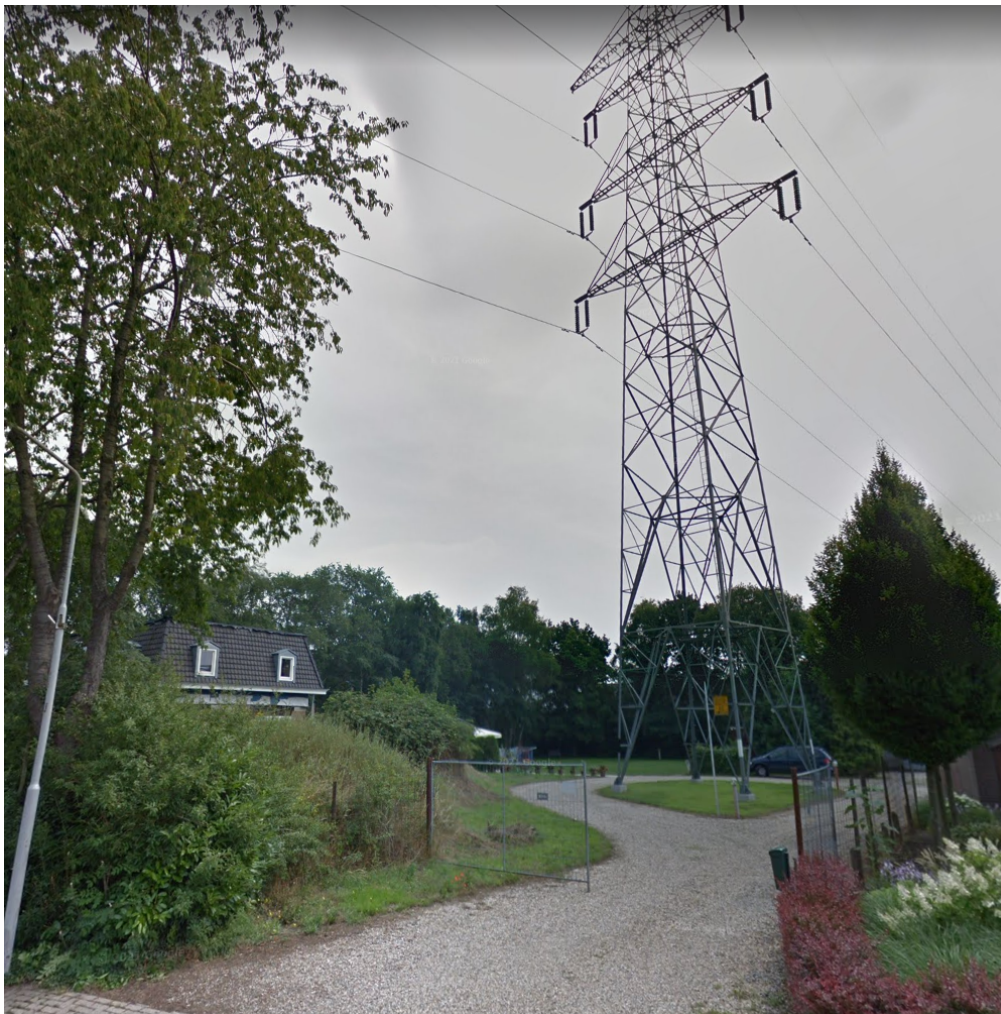
Figuur 2.1: straatbeeld vanaf de Dorpsstraat met de bedrijfswoning Dorpsstraat 40 (bron: Google Maps)
