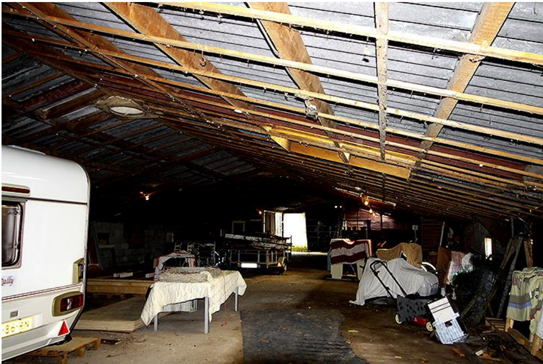
Plangebied zicht in zuidelijke richting
