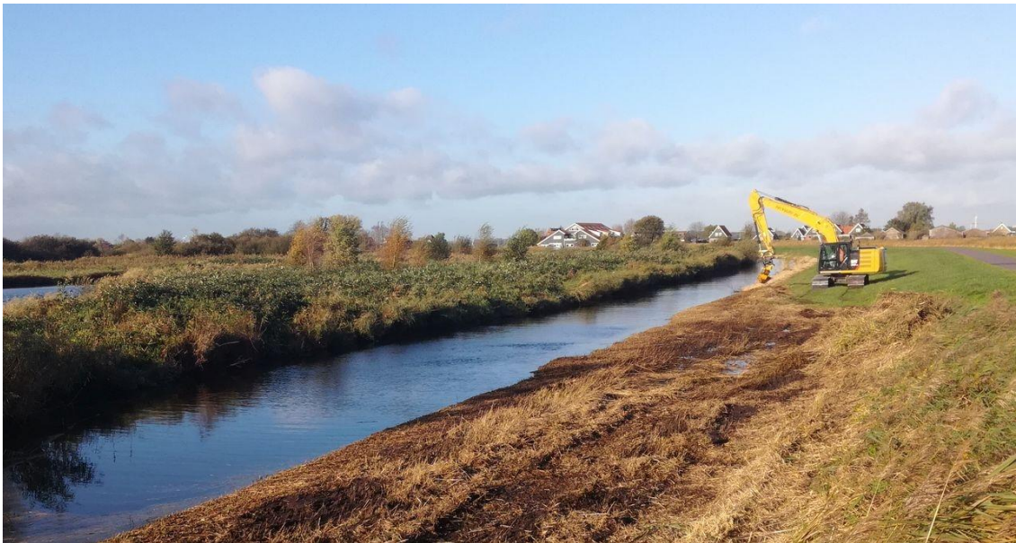
Foto 3.7. Glad schrapen van het sloottalud aan de noordzijde van de Ekkers, oktober 2020.
