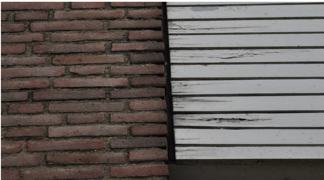
Hermetisch afgesloten kieren en gaten.
