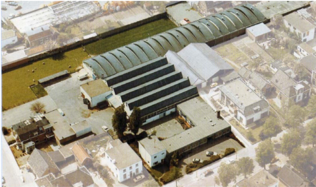
afbeelding: Luchtfoto van fabriekscomplex met herkenbare schaal- en sheddaken
