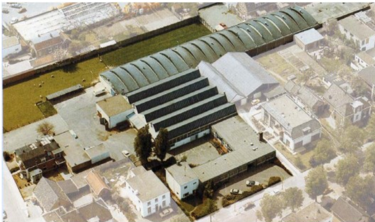
Afbeelding 4: Luchtfoto van fabriekscomplex met herkenbare schaal- en sheddaken
